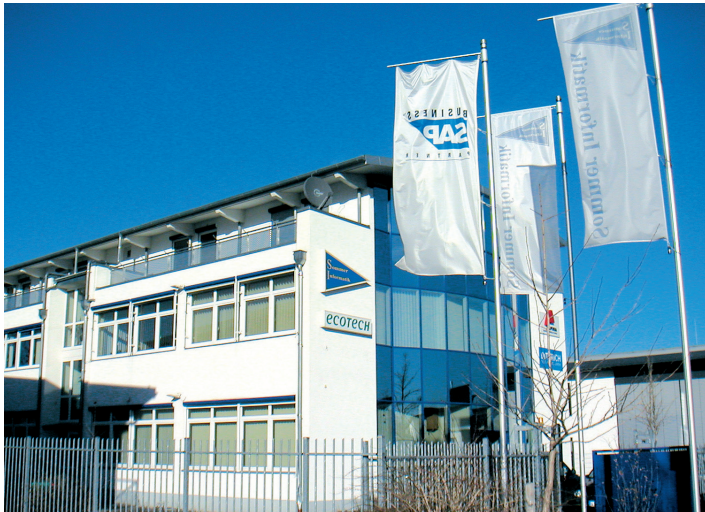
Das SI-Firmengebäude in Rosenheim/Schwaig
